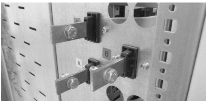
◀ Пример установки изолятора ИНП
